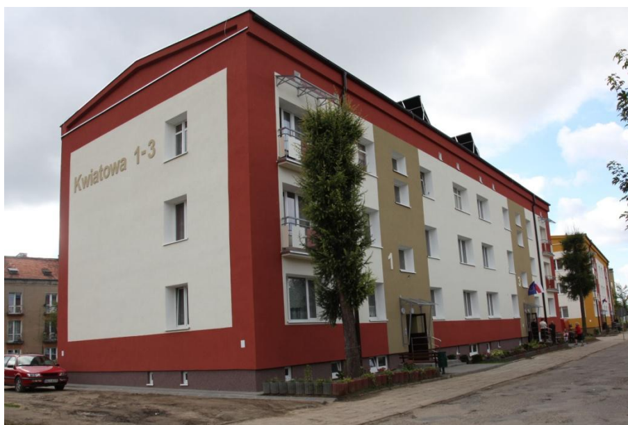
fot.7. Budynek przy ul. Kwiatowej 1-3 w Orniecie po remoncie
