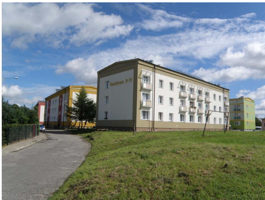
fot. 28. Widok wyremontowanych budynków
