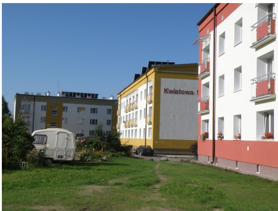
fot. 30. Widok wyremontowanych budynków.
