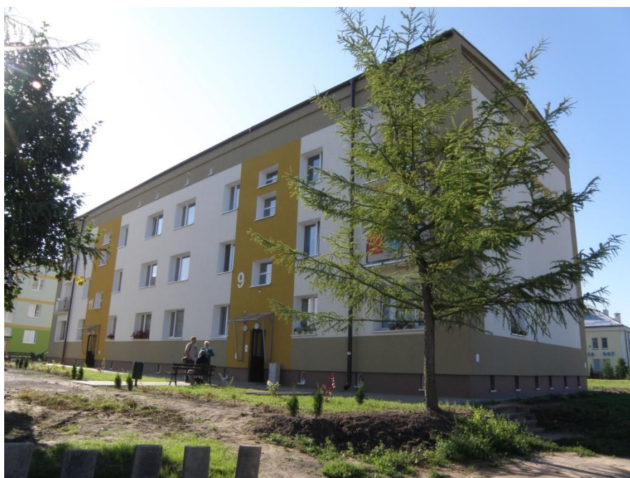
fot.14. Budynek mieszkalny przy ul. Kwiatowej 9-11 po remoncie.
