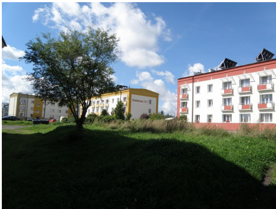
fot. 29. Widok wyremontowanych budynków
