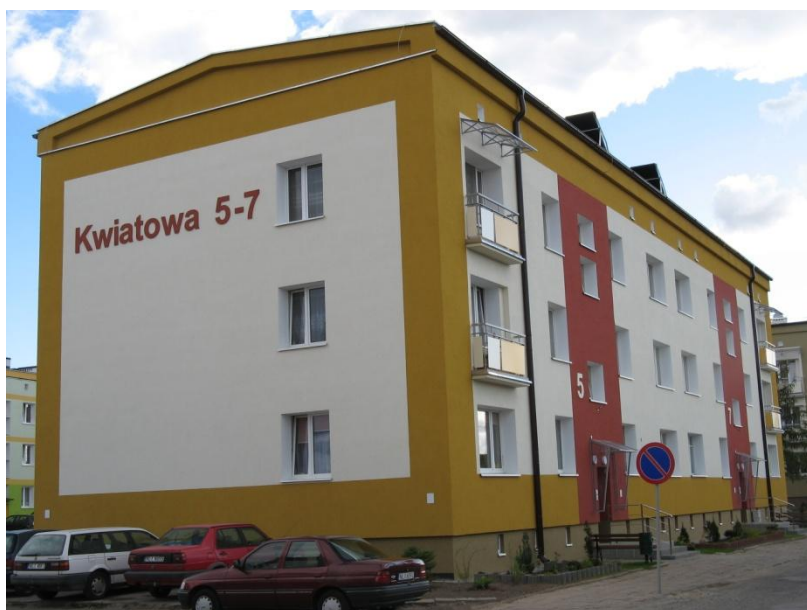
fot. 11. Budynek przy ul. Kwiatowej 5-7 po remoncie
